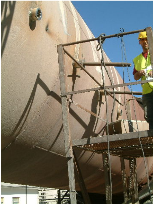
[ Cardox Tube의 삽입을 위해 뉴메틱 로타리 드릴로 Build-ups에 구멍을 뚫고 Tube를 작동 시켰다 ]
