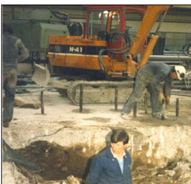
[ 콘크리트 기계기초 제거 ]
