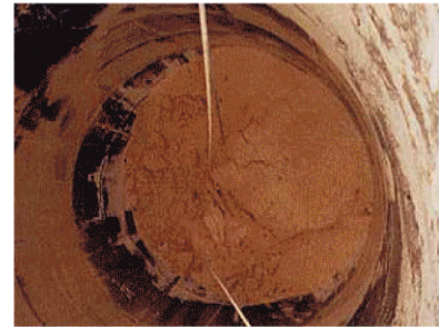
[ 싸일로 내부에 발생한 Build-Up에 카독스를 적용하기 전(L)과 후(R) ]
